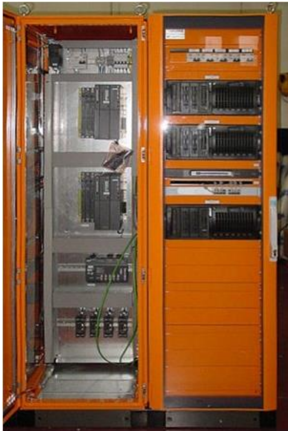
Рисунок 2.10 – Шкаф контроллера
